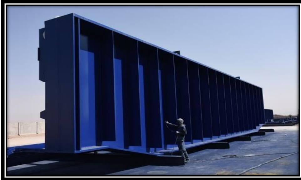
ساخت و رنگ آمیزی تیر جرثقیل ۲۸ متری توسط شرکت شکوفا صنعت پویا
