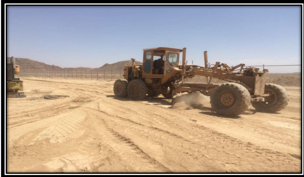
عملیات تسطیح و رگلاژ توسط ماشین گریدر (پروژه پویان گهر)
